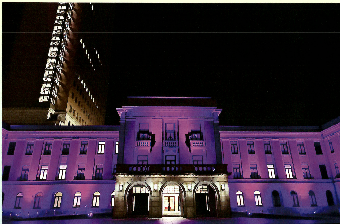
撮影：暴迫センター職員（群馬県庁昭和庁舎）
